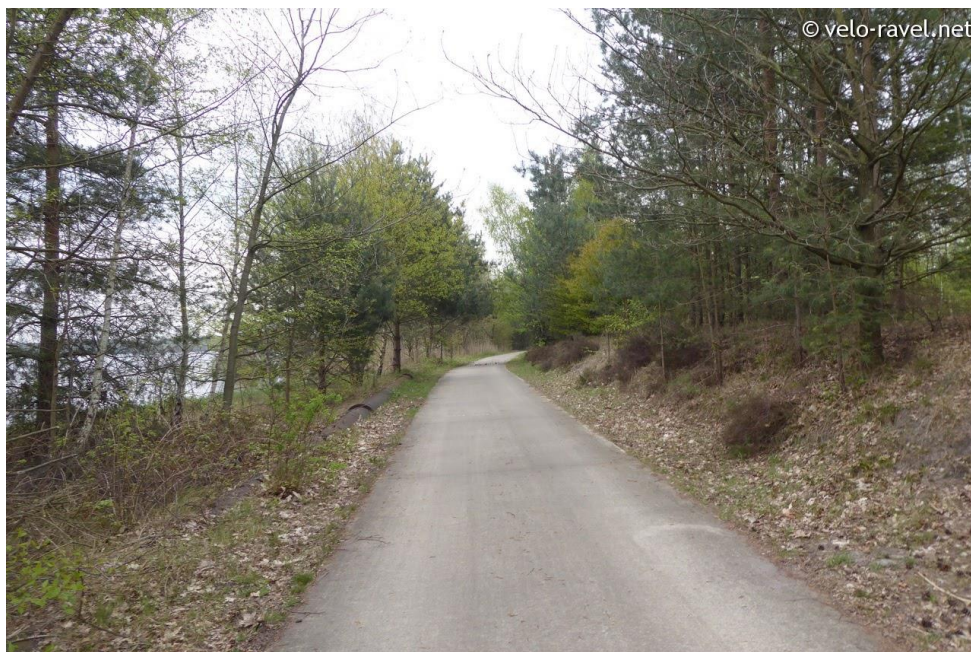
Illustratie 11.12: Huidig beeld op de bovengrondse, metalen zandwatertransportleiding langsheen het fietspad aan de zuidelijke rand van Kanaalplas (Hoofdpoort) (Foto Velo-ravel.net)
